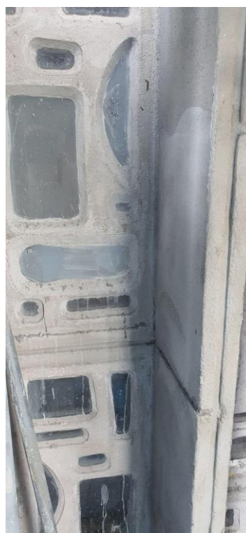
Pierwsza warstwa mikrozapraw - pędzel
