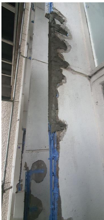
Wstępne uzupełnienie zaprawami PCC
