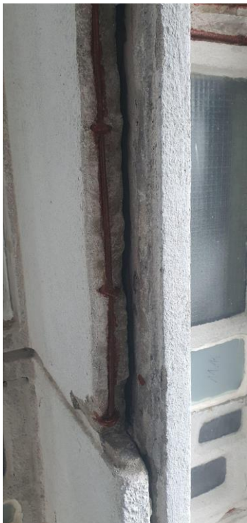
Wstępna warstwa antykorozyjna
